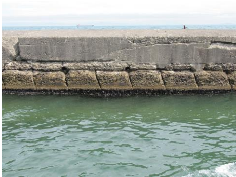
写真-19 北防波堤の斜塊ブロック
