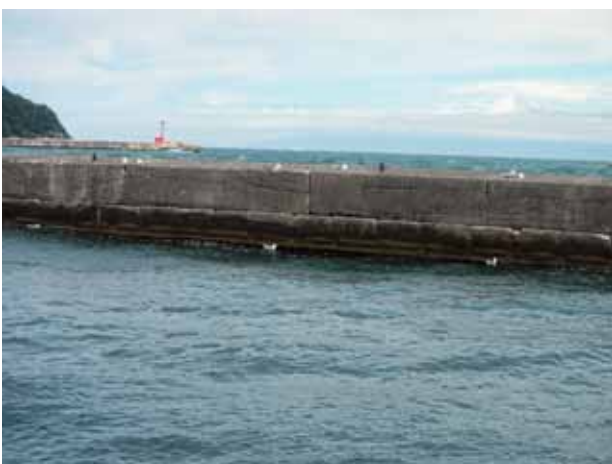
写真-5 北防波堤の斜塊ブロック
